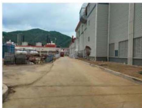
现有工程厂区-污水处理站附近
