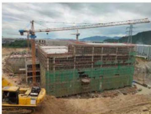
本项目施工现场
